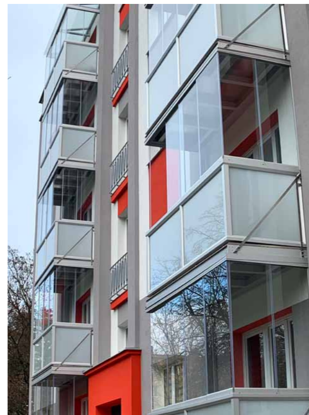
RAILOG® závěsné balkóny + zasklení závěsných balkónů bezrámovým posuvným systémem Winlog® Bytový dům Kopřivnice ul. Obránců Míru
