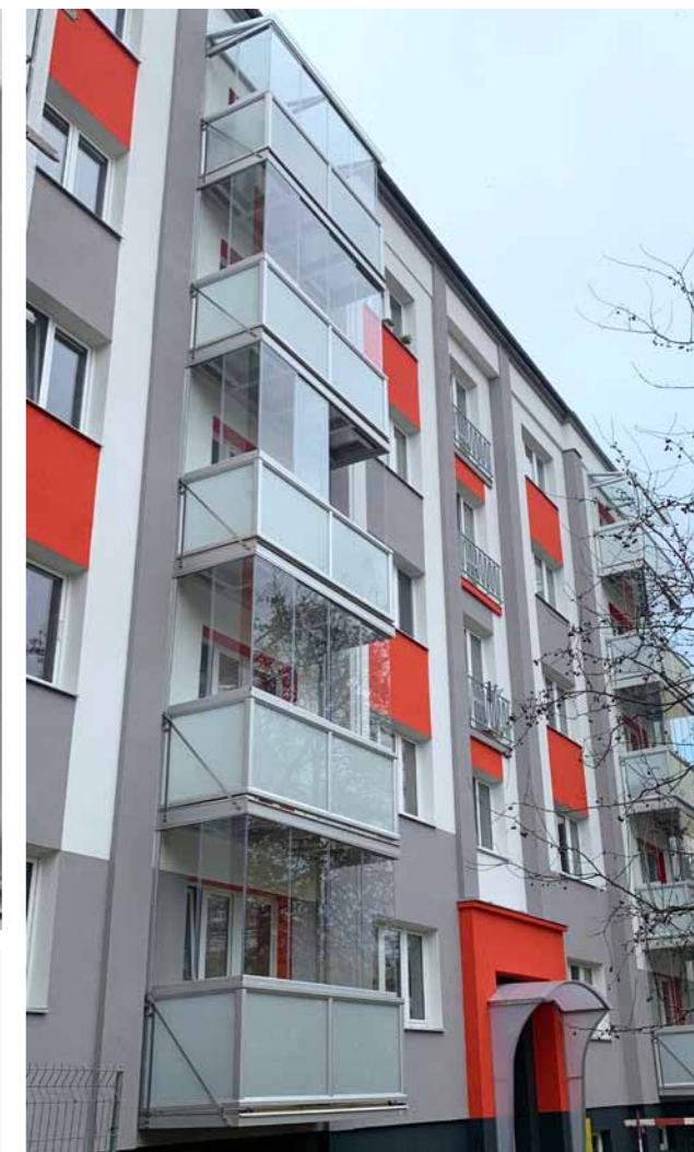
RAILOG® závěsné balkóny + zasklení závěsných balkónů bezrámovým posuvným systémem Winlog® Bytový dům Kopřivnice ul. Obránců Míru
